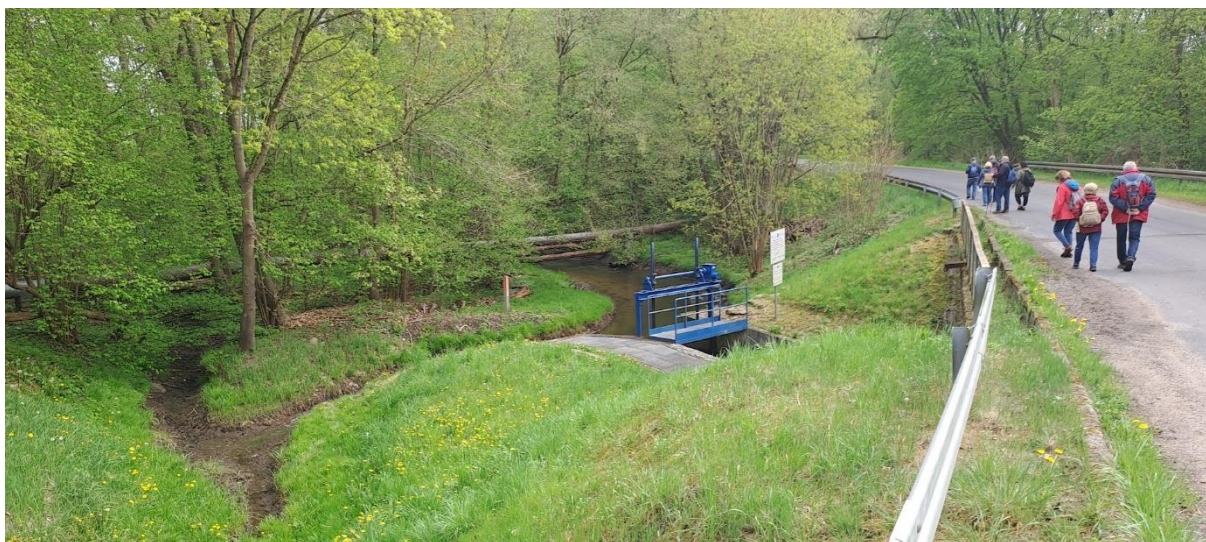
Po drugiej stronie drogi widoczna śluza która spiętrzała wody Iny, aby doprowadzić ją do kanału młyńskiego
